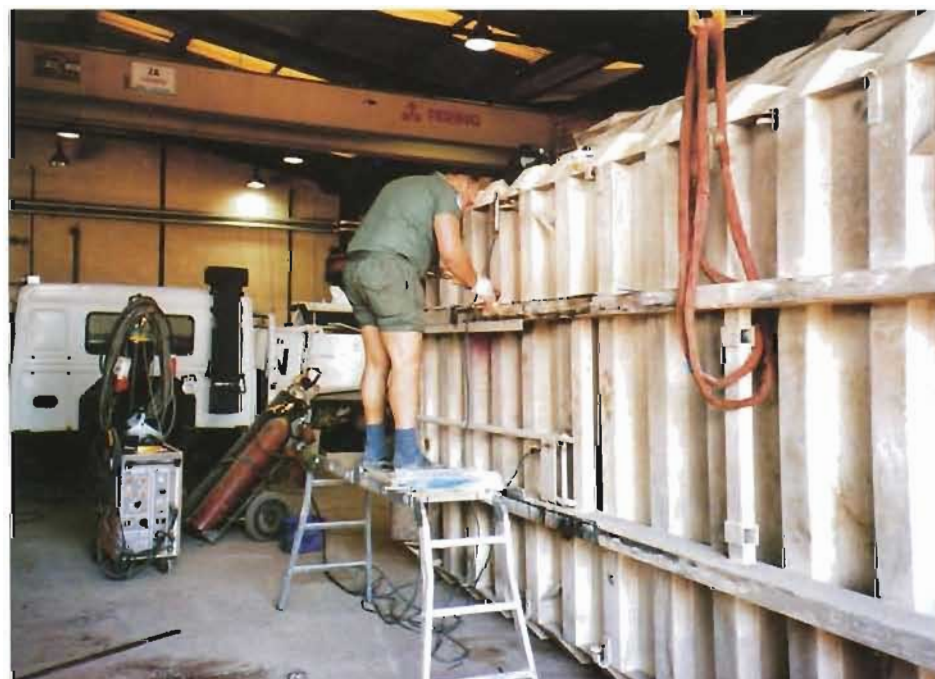
Förstärkning av ramen till ett grusflak. Svetsare Lindström, 3:e tunga reparationsgrupp.
