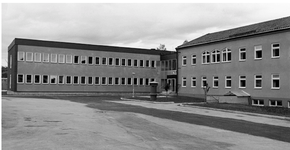
Under 1972 blev den efterlängtrade nya administrationsbyggnaden färdigställd
