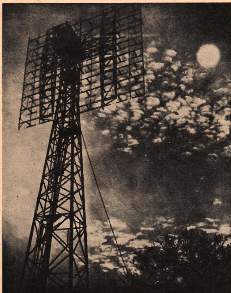
Den radloan- tenn som an- vändes för att åstadkomma kontakt med månen under experimenten vid Bradley Beach.
