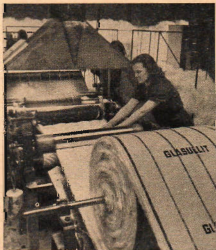
Svensk maskin för tillverkning av isolermattor av glasull.
