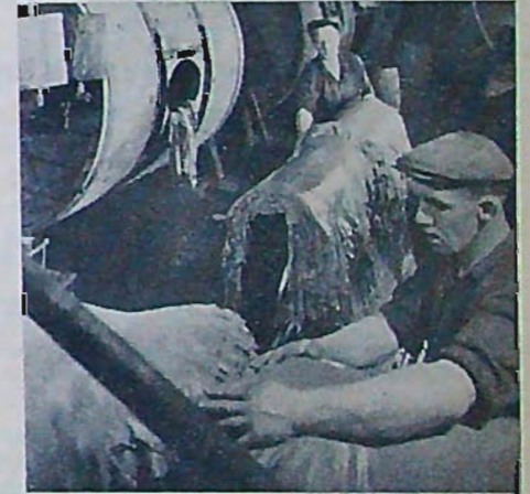
Vid kromgarvning behandlas hudarna i valkar, stora roterande fat, med lösningar av basiska kromsulfater.
