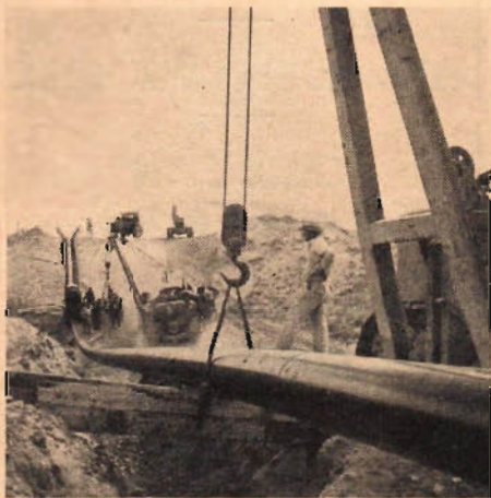
En mindre "pipe-line" lägges.
