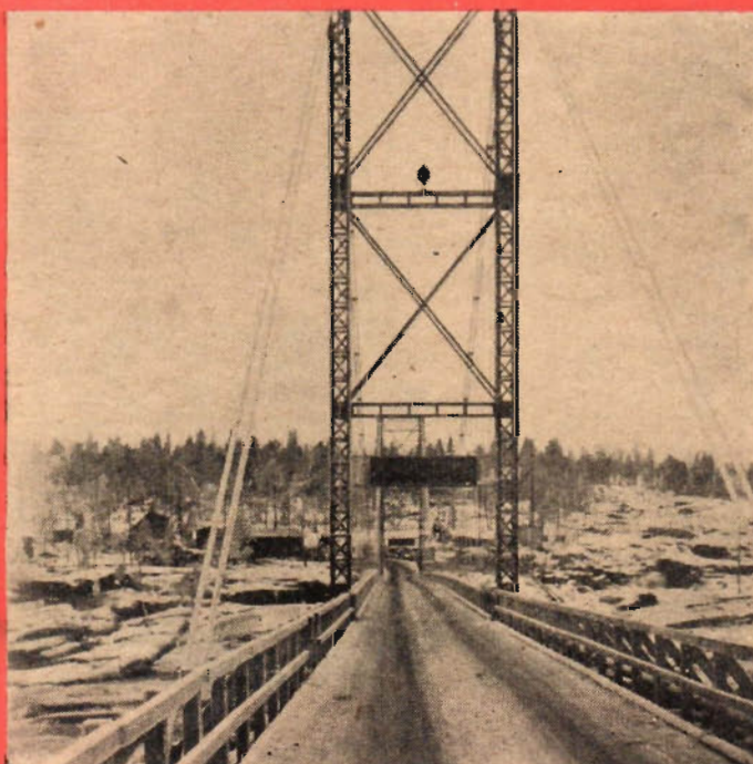
Överst en vy av arbetsplatsen med några byggnader från det tidigare anläggandet i bakgrunden. I mitten en bild från hiss-schaktet till kraftstationen och nedst en pampig bild av den provisoriska hängbron.
