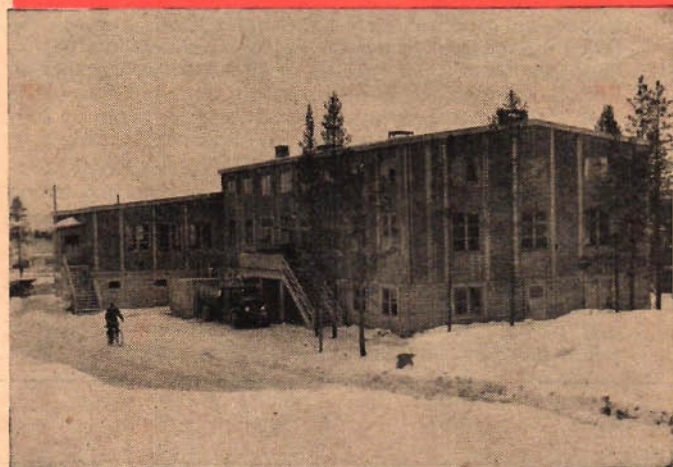
Marketenteriet är en imponerande byggnad, modernt inredd.
