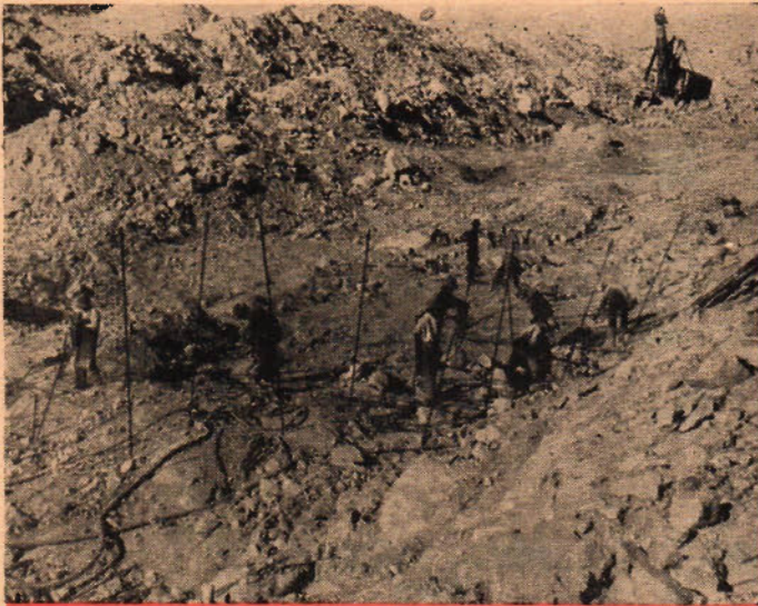
Råämnet för jod, caliche, ligger vanligen på några meters djup, täckt av onyttiga jord- och stenlager. Mäktigheten varierar från några tum till tre à fyra m. Språnghått borrar med tryckluftdrivna bergborrmaskiner ned till calichen, som friläggs genom på elektrisk väg avfytrade svartkrutladdningar.
