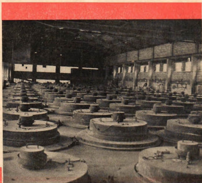
Kalkkvivegnar, s. k. burkugnar, vid Stockviksverken.
