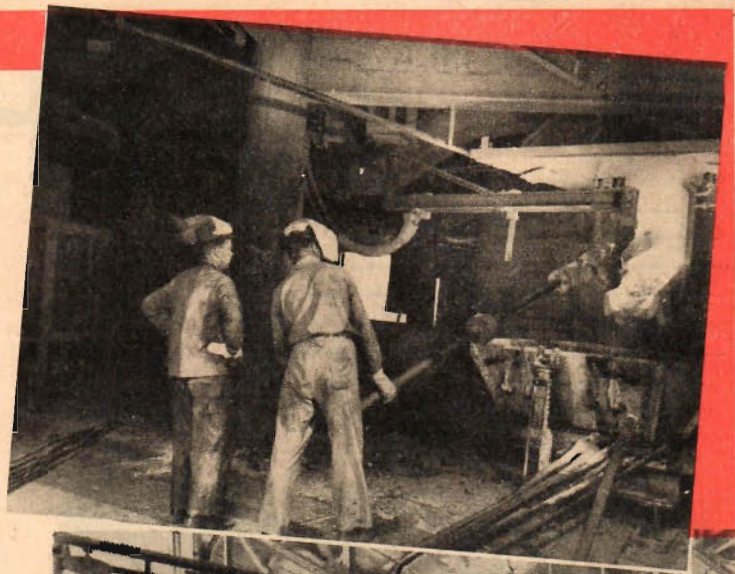
Tappning av karbid vid Stockviksverken.
