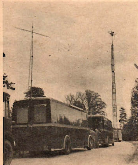
T. v.: En av BBC:s televisionspatruller. Främst upptagningsvagnen, därefter sändarvagnen och längst fram antennvagnen. T. h.: En upptagning från en boxningsmatch i London, och därovanför en upptagning i det fria — på en av Englands otaliga kanaler.
