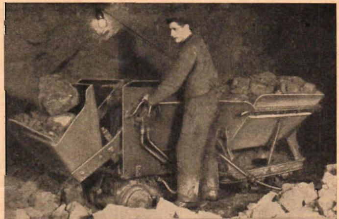
Utlastning av loss-skjutet berg hjälp av tryckluftsdreven lastningsmaskin.
