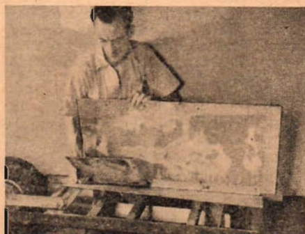
Tre lager av olika material bildar golvet. I botten av bit masonite, i mitten en plåt av järn och överst aluminiumplåt.
