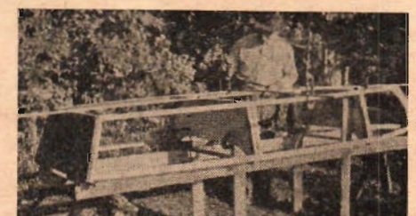
"Kölsträckningen" är klar och masonitebeklädnaden kan börja.
