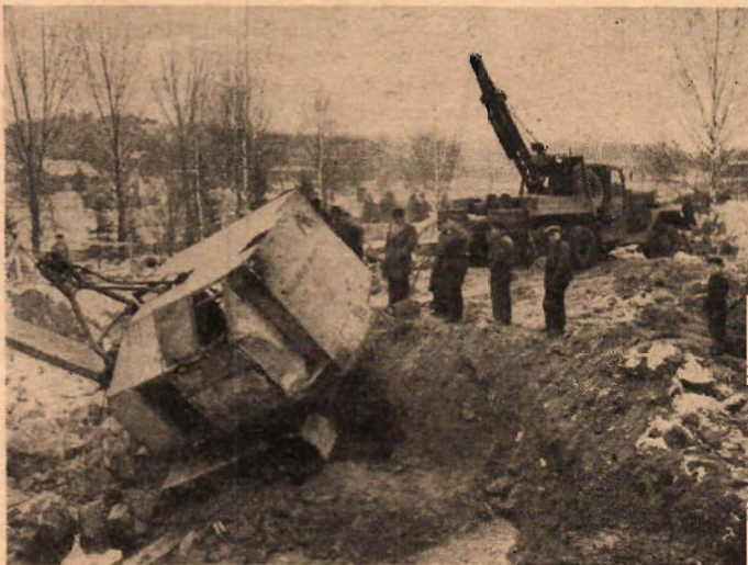
Under bärgningens gång.
