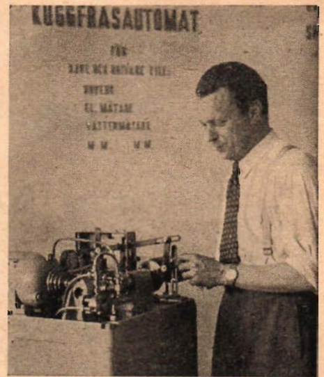
Den första helautomatiska svenska kuggfräs-maskinen för precisionsfräsning av mycket små hjul.
