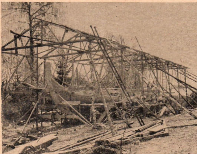
Vikingaskeppet under byggnad vid Stensund.
