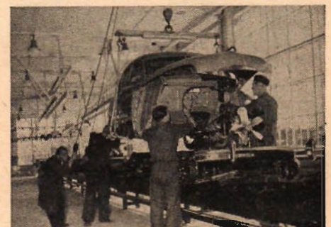
T. h. Karossen placeras på chassiet. Ovanför rubriken en flygbild av den nya anläggningen.
