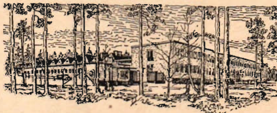
Elektrolux nya Västerviksfabrik för storproduktion av småmotorer
