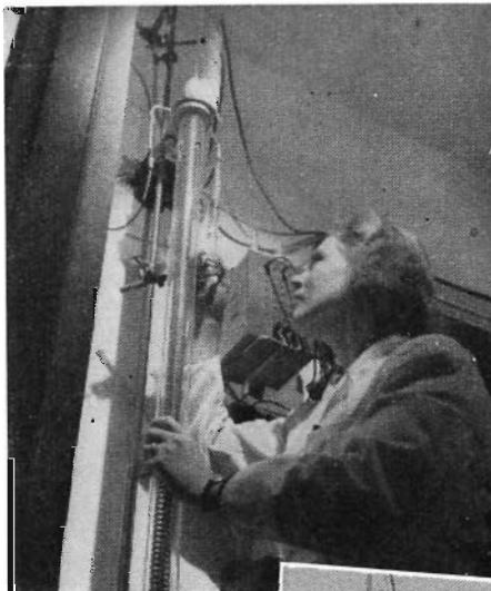
Den övre bilden visar en ung dam, som i AB Bofors Nobelkruts Kemiska forskningslaboratorium är sysselsatt med Skärblom-Linders destillationsapparat. Därunder en interiör från samma företags testrum på kemiska forskningslaboratoriet.
