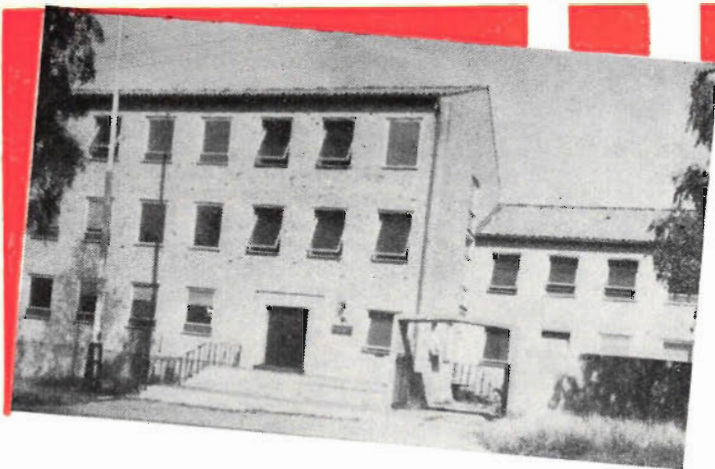
Det nyuppförda Metallografiska institutet, som från ett blygsamt laboratorium vuxit ut till centralt forskningslaboratorium för järn- och metallindustrin.
