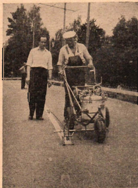
Vad som var nytt i USA var redan en gammal bekant i Stockholm. Detta tryckluftsdrivna sprutmålningsaggregat har i år byggts av Atlas Diesel för Gatukontorets i Stockholm räknning.
