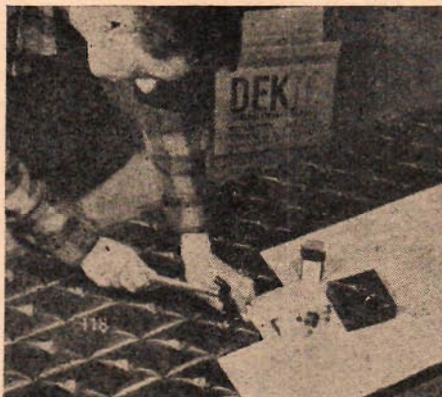
När ramlisten satts fast så spikas plattorna fast på plywoodskivan. Se till att synligt trävirke målas dessförinnan.
