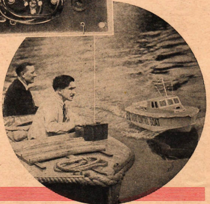
Mottagaren har 3 kanaler, var och en betjänande ett relä, som i sin tur påverkar servomotorerna. Båten har dubbla roder.
