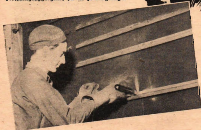
Nedan: Arbete med det amerikanska punktsvetsningsaggregatet på en järnvägsvagn.
