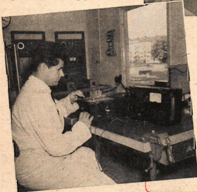
På bilden ovan kontrolleras spänningen hos en pennodosimeter i en speciell apparat — denna kontroll sker en gång i veckan och avslöjar om bäraren har utsatts för strålning. Kontrollanten bär på vänstra rockslaget, som framgår av bilden, dels en pennodosimeter, dels ett med film laddat fodral, försedd med ett metallfilter. Filmerna jämförs direkt med bestrålade filmer i en filmsvärtmätare — på bilden här till vänster är civ.-ing. B. Heyman fotograferad vid denna apparat.
