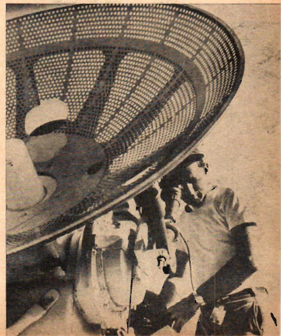
Under flygproven med Skyrocket följs planet av radar. Teknikern ser planet genom ett teleskop inbyggt i radarreflektorns centrum.
