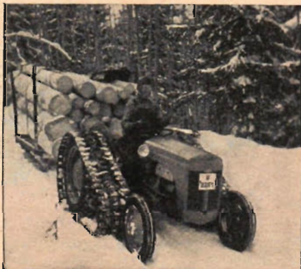
Den vanliga lätta hjultraktorn blir en bra skogshäst om den förses med halvband, och här kommer en Ferguson-traktor utför backen med ett kraftigt lass.
