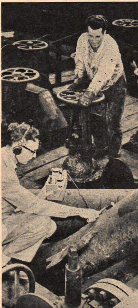
Tre användningsområden för "atomen i overall". Här ovan undersöker Standard Oils män strömningshastigheten och var den ena oljekvaliteten börjar och nästa slutar i ledningarna med hjälp av "märkta" atomer.
