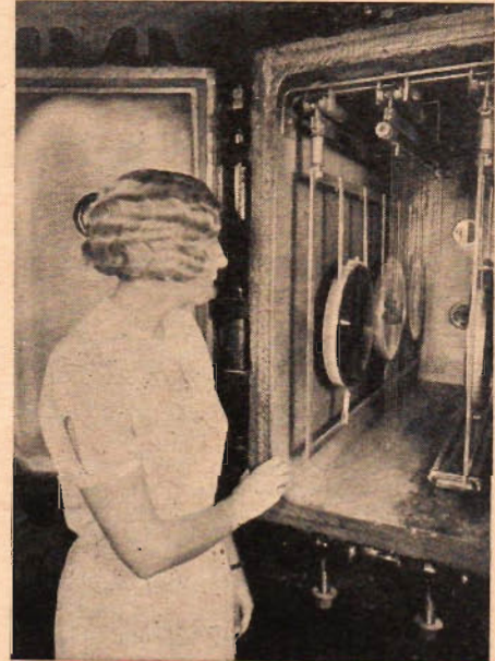
I en evakuerad gjutjärnsbox hänger mellan rader av graverade plattor ett antal tunna silvertrådar. Under inverkan av ett högspänt elektriskt fält förstoftas silvret, som avsätter sig som en ytterst tunn hinna på lackplattan. På silverhinnan utfälls på elektrogalvanisk väg ett tjockare kopparskikt, vilket förkromas.
