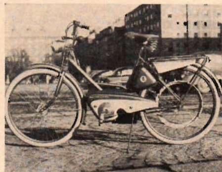
Husqvarna Novolette 1954 har fått rullhandtag för handbroms till framhjulet.
