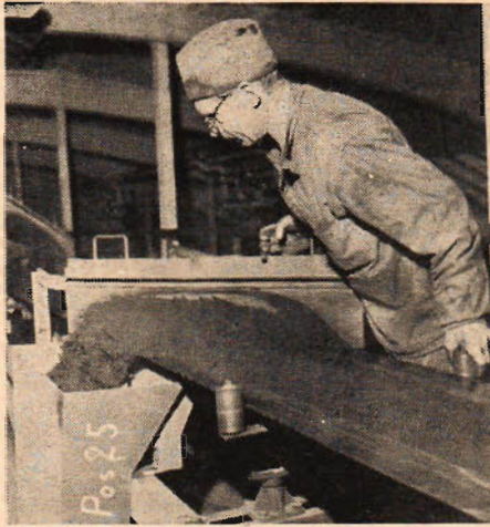
Sanddistributionen. På gummiklädda band-transportörer går sanden ut till olika sand-silor vid forningmaskinerna.
