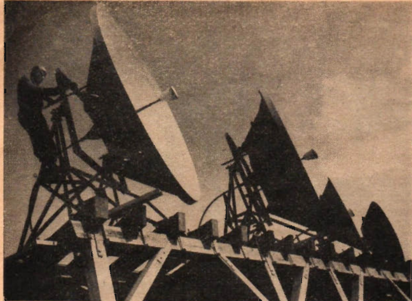
Relästationer vid Schönberg i bergsområdet Eiffel nära belgiska gränsen ligger så högt att torn inte behövs. Där använder man också vindmotorer som drivkraft.
