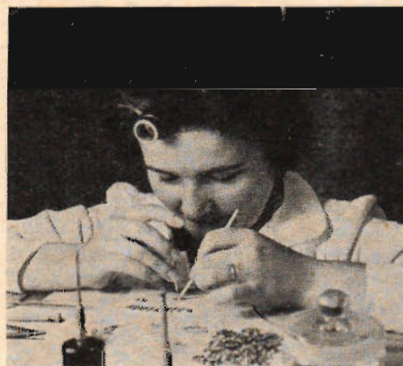
Den schweiziska urfabriken Universal-Genève lanserar snart Microtor, världens tunnaste självuppdragande ur. Konstruktionen bygger på en ny osymmetriskt placerad miniatyrrotor. Bilden i. v. visar en synål jämförd med rubiner och andra detaljer i Microtor. T. h. monteras det nya automat-uret.
