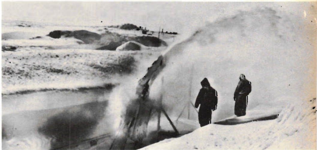
All söndermalad is, som sågats ut i underjorden, forslas via snöslungor upp till markytan. Så när som på en barack är denna snökastning det enda som röjer "stadens" läge. Bilden ovan visar snöslungan.
