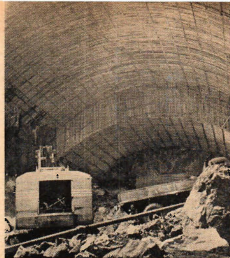
För närvarande pågår arbetet med den underjordiska reaktorhallen i Studsvik. Bilden visar betonggjutningen av tak i berggrummet.
