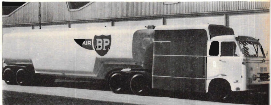
Världens största tankvagn kan numera beskådas på Arlanda, där den skall sörja för att jet-jättarna får tillräckligt med bränsle för nästa luftskott. Vagnen är en Scania-Vabis L75, som Bröderna Forss i Mjölby försett med den jättelika tanken av lättmetall. Lastkapaciteten är 52 000 liter och det 17 m långa, 2,45 m breda ekipaget väger med full last inte mindre än 63,5 ton.
