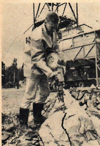
En bergbormaskin användes i grustag för spräckning av sådana stenar som är för stora för krossverken.
