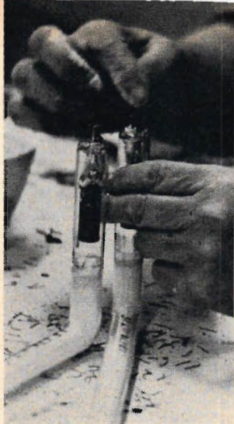
Här förses de nya elektroderna (med kvicksilverfälla) med anslutningskruvar, vilka fästes med lampsockelkitt.
