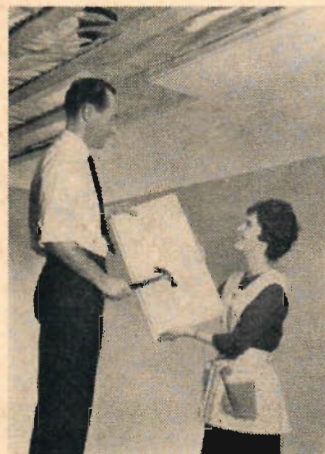
Man kan sätta nya tak i bebodda rum utan att förstöra tapeter eller väggar.
