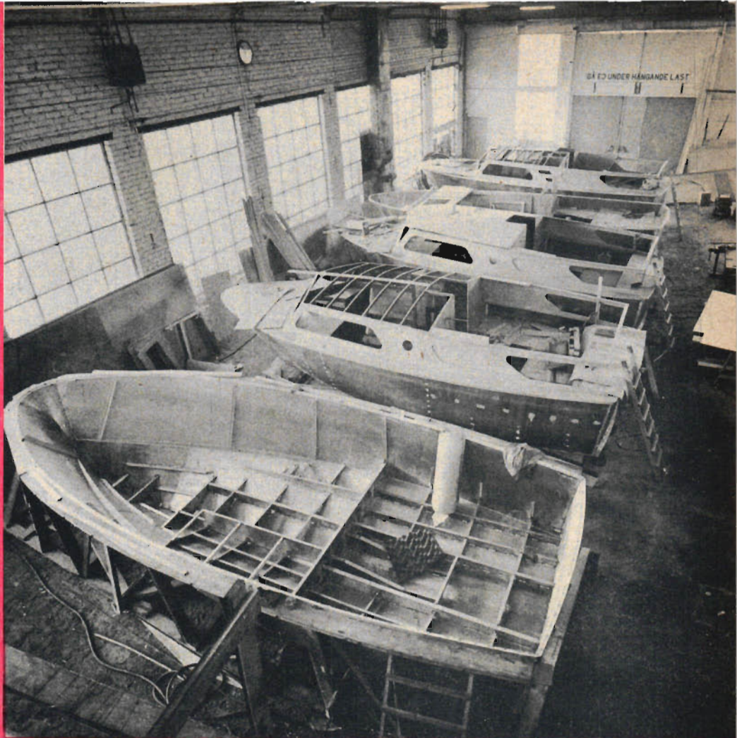
Här är fem av Boghammars kabinkryssare Cabinen under arbete. Lägga märke till lättmetallförstyvningarna i botten på den närmaste av båtarna. Bottenvägare och bottenstockar styrar upp konstruktionen och ger också fäste för motorbockarna. Tjockleken på plåten i bordläggningen är 4 mm men skrovet stagas ändå upp av spant.
