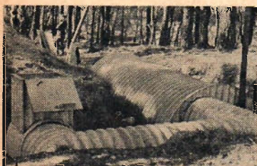
Den korrugerade plåten täcks över med jord och sten.
