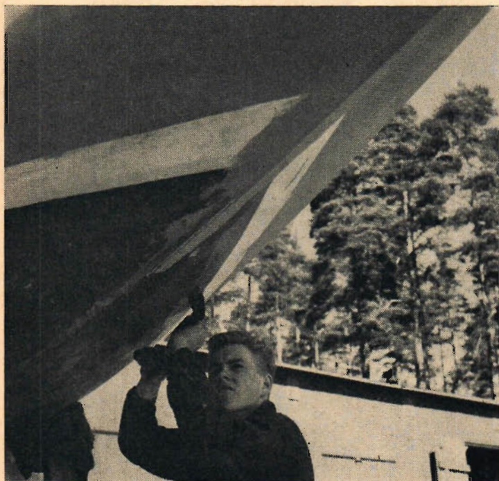
Den ofta besvärliga "värskrapningen" av båten underlättas betydligt av Interskrapan med dess knivskarpa skär av Coromant.
