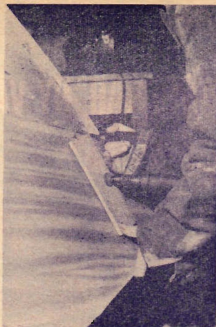
2 Ett av de förliga sidoborden passas in. Böjningen är avsevärd vid fören och det behövs rejäla tvingar för att pressa in det kraftiga plywoodbordet.
