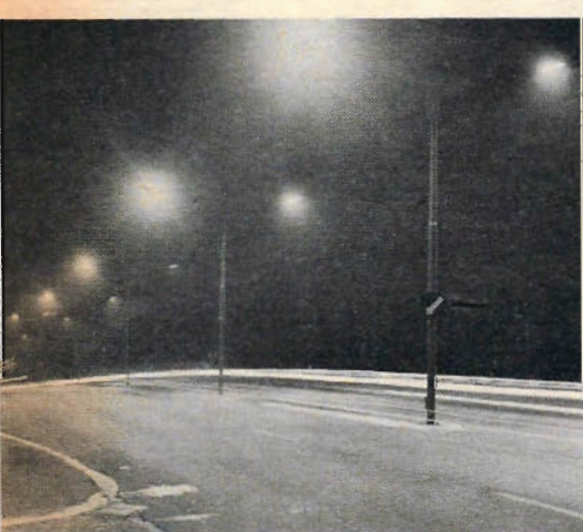
I höjd med Riksmuseet vid Frescati tar vi det första exemplet: Natriumljus från stolpar placerade mellan vägbanorna.
