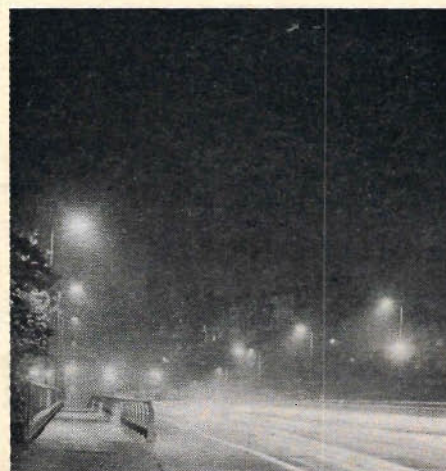
Nu kommer Danderyd med vita kvicksilverlampor monterade på stolpar, som placerats parvis på ömse sidor om vägen.
