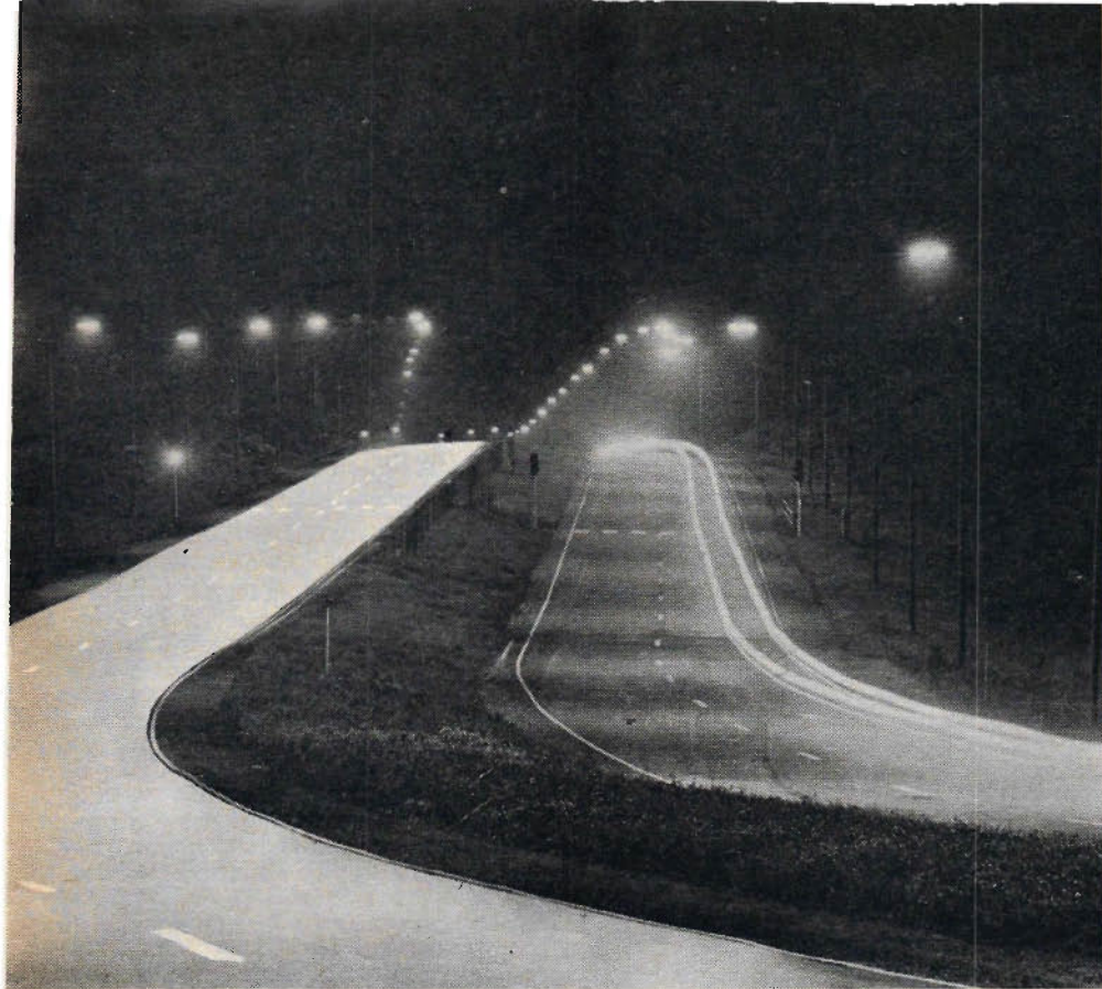
Det finns tyvärr inte så många vägar i vårt land som har belysningar som kan tjäna som goda exempel. Tyresövägen söder om Stockholm har dock försetts med en belysning som får ett gott betyg.
