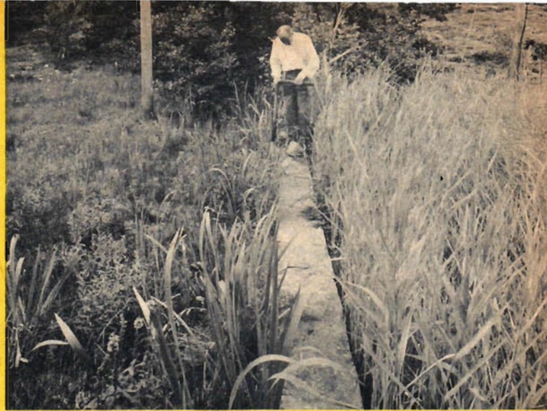
En sank vik förvandlas till blomstrande äng med hjälp av en damm och en hävert — i detta fall med ett u-format vattenledningsrör. Lägga märke till skillnaden i vegetationen innanför (t v) och utanför dammen, vars skänklar måste vara lika långa för att man lätt skall kunna fylla och starta den.
