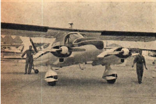
Dornier är ett av de gamla kända tyska flygplansnamnen. Do 28 är ett 6-8-sitsigt högvingsat plan med två Lycoming-motorer på vardera 255 hk. Spännvidden är 13,8 m och toppfarten 280 km/tim.
