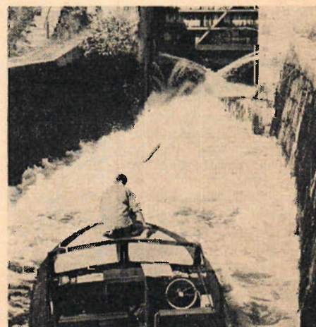
Strömmen är stark när vattnet släpps på och detta gäller inte minst i de tredubbla slussarna. Båten har här förtöjts i den ur berget sprängda slussen vid Dals Långed.
