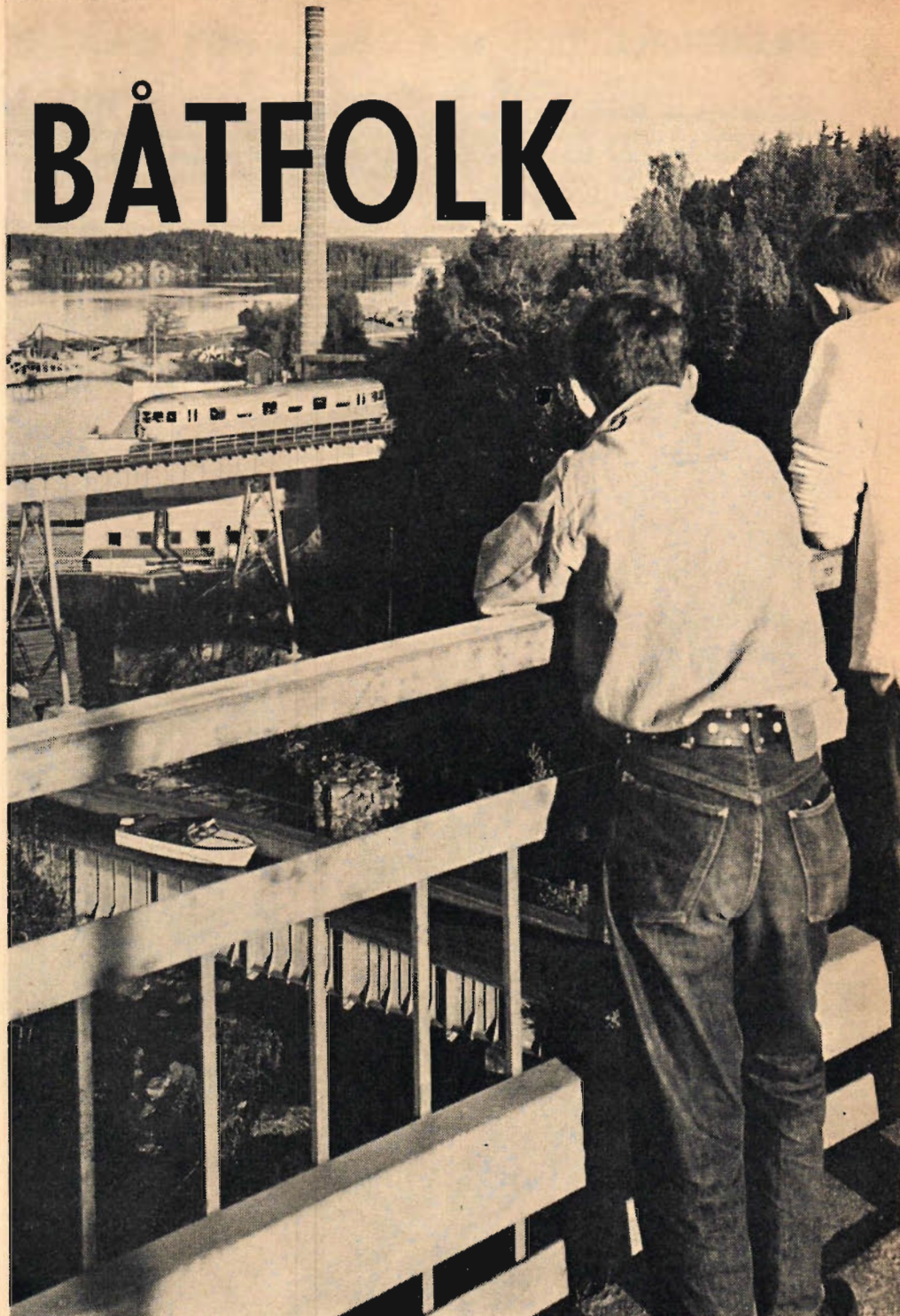
Akvedukten i Häverud är en välkänd turistattraktion. I den 32 m långa plåtrännan glider båtarna fram över en strid forsen och 50 m över kanalen spänner en landsvägsbro över den djupa ravinen. Även järnvägen passerar här Dalslands kanal.
