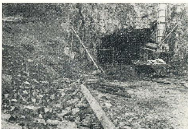
Bergsinfart med ventilationstrumma. Fotografiet taget den 26 augusti 1943.
