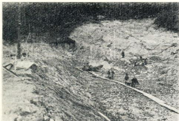
Klart att börja borra för sprängning. Fotografiet taget den 15 april 1943.
