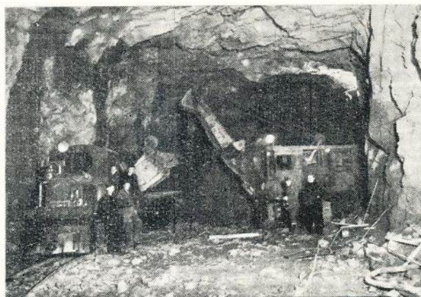
Grävsropa med en vikt av 40 ton under arbete i CVA-berget.
