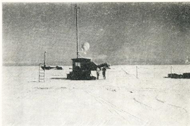
Pejluhyddan uppmonterad och klar att ge radio-kontakt och vägledning åt flygarna.
