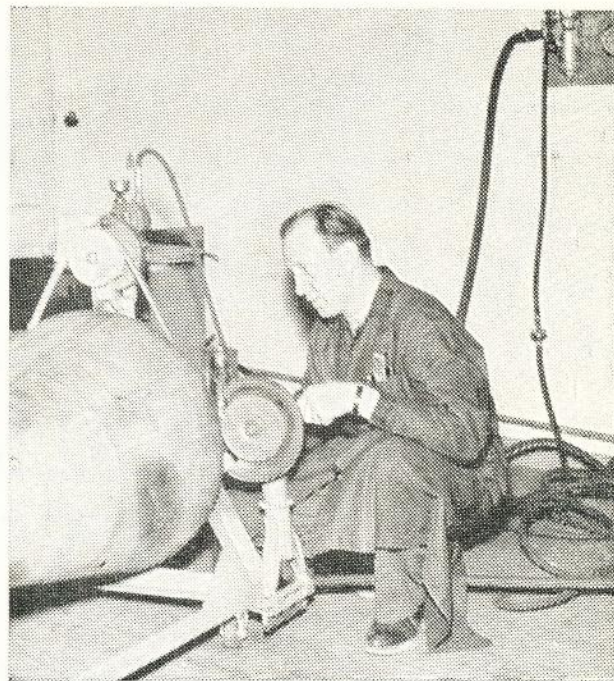
Karl Raattamaa i grubblarposé framför sin fiäntur för slipning av utloppskon. Ett förslag som medfört stor tidsvinst och belönats av FF.
