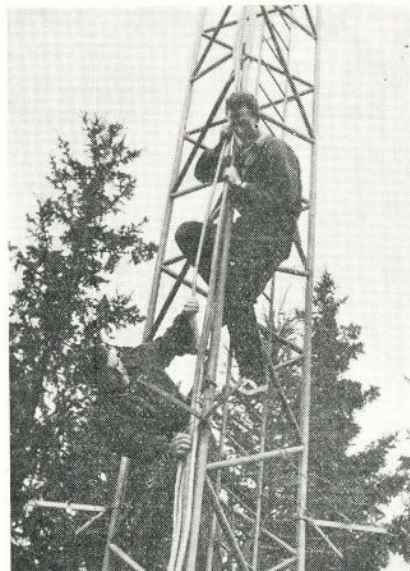
Lennart Lundberg (nederst) och Arne Söderberg sträcker kabel i länkmast
