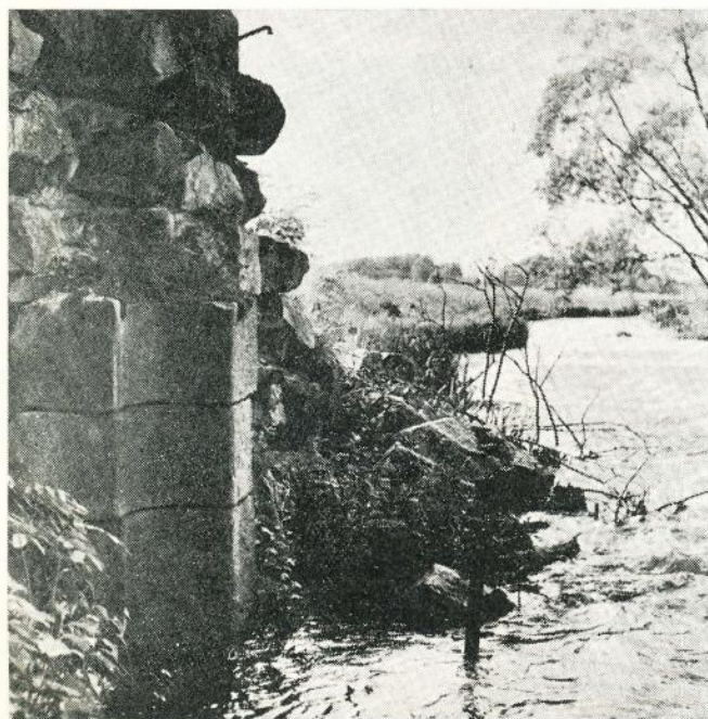
Bild 5. Fogstenar och beslag i Ängsslussen.
