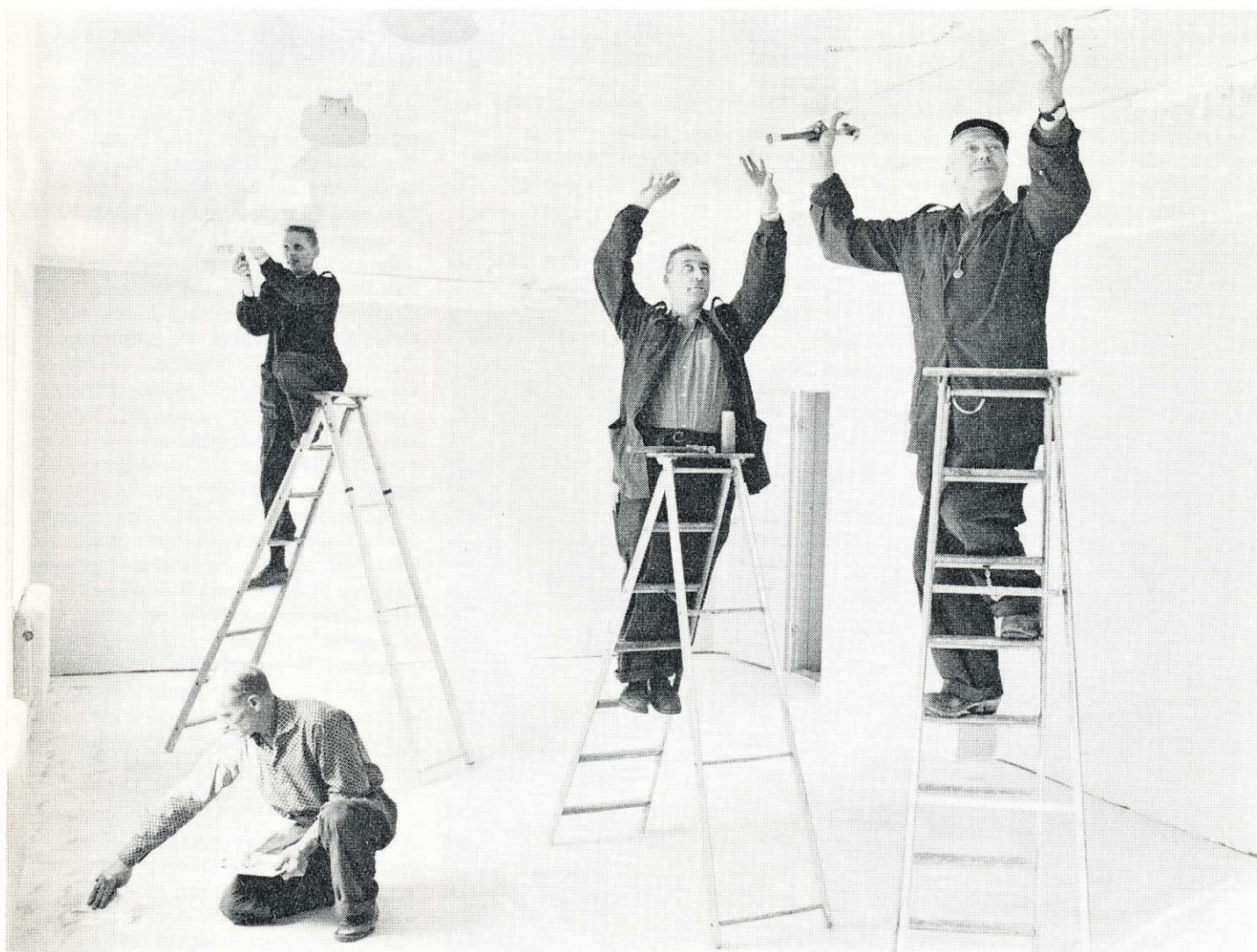
Ombyggnadsarbetena i Asby går raskt undan. I en blivande lektionssal bättringsspacklar John Olsson golvet, Gunnar Eklund monterar lysrörsarmaturer, Lennart Andersson och Nisse "Ettan" Eriksson spikar taklist. Foto Reinhold Carlsson
