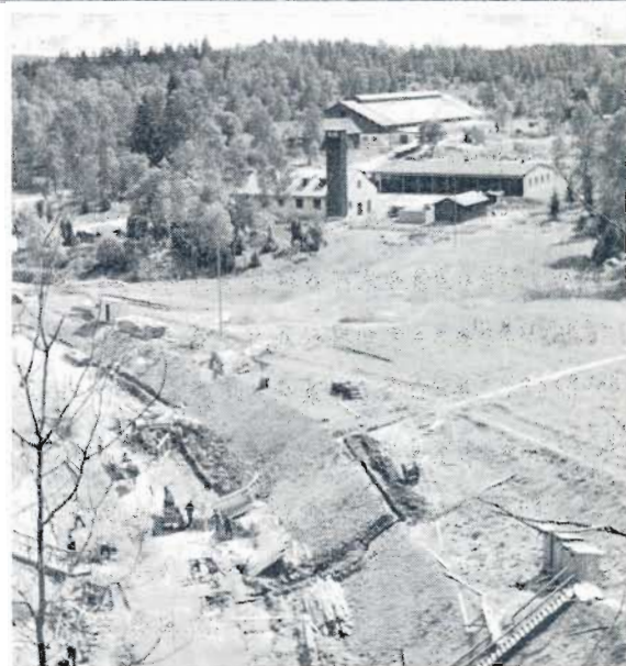
Bergsinfarten schaktas fram.
