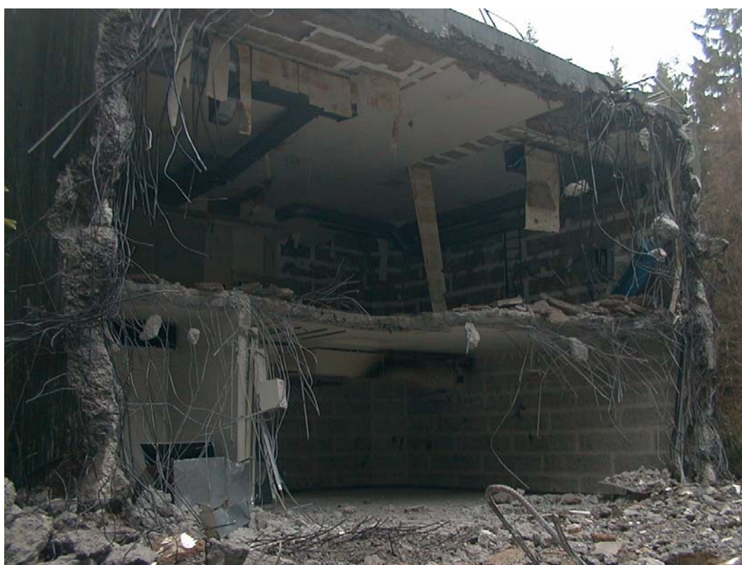
Bunkerns armering var omfattande vilket avslöjades vid rivningen.
