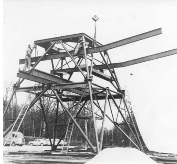
Montering av övre tornhalva med plattformsbalkar.
