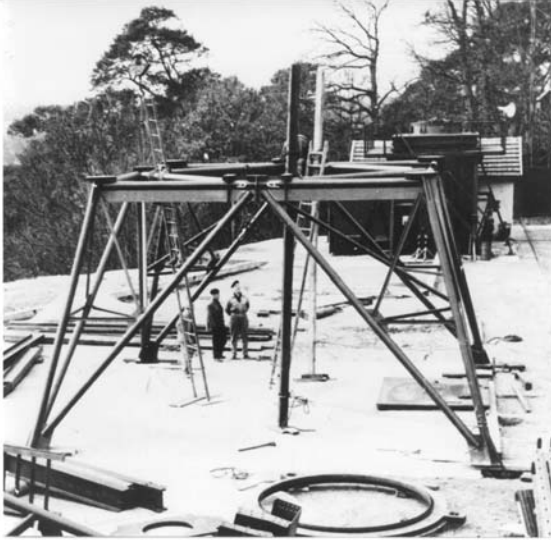
Montering av nedre tornhalva
