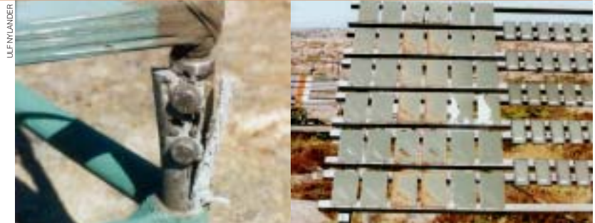
Ingredienserna är viktiga. För mycket koppar i denna aluminiumlegering har fått materialet att korrodera sönder.
