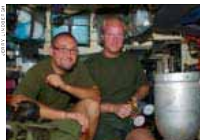
Mattias Spångberg och Fredrik Svensson kontrollerar luftkonditioneringsaggregatets förångningstryck i en Pansarterrängbil 203.
