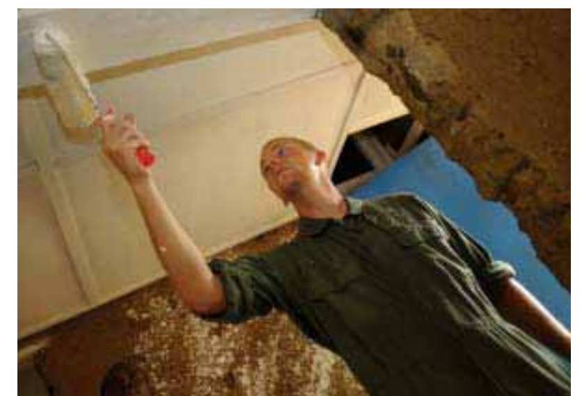
Björn Lindau är en av de soldater som hjälpt barnhemmet med uppfräschning av deras pojkhuis. Nytt tak och invändig målning har stått på görolistan.
