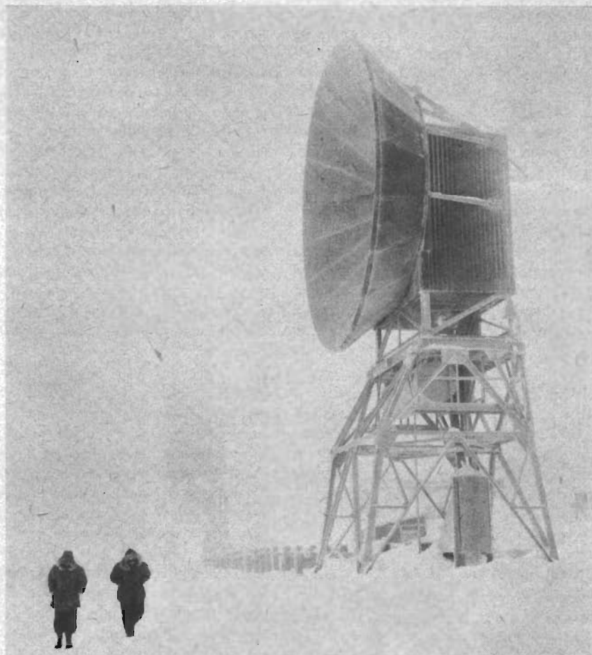
USA har upprättat en kedja av radarstationer från Alaska i väst till Grönland i öst, som har till uppgift att varna mot flygangrepp. Praktiskt taget samtliga de stationer som ingår i radarkedjan är placerade i områden med mycket hårda klimatiska förhållanden, vilket givetvis ställer extra hårda krav på inte minst den elektroniska materielen.
