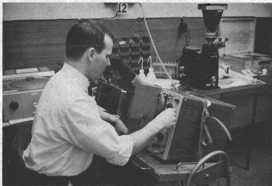
Fig. 15 Ingenjör Per Eklöf mäter kapacitansen i spärskiktet till en halvledare i felanalysgruppens laboratorium. I bakgrunden ett mikroskop med Polaroidtillsats.
