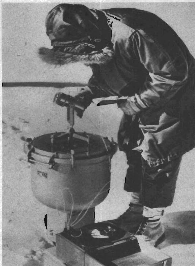
Under det internationella geofysiska året var en rad amerikanska vetenskapsmän sysselsatta med mätningar i Antarktis. Det trumliknande instrument som visas på bilden används för mätning av strålningen i luften. Mätvärdena indikeras på instrumentet i förgrunden. Det tycks gå med vanliga instrument i polarklimat också.
