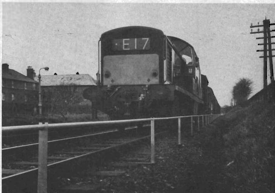
Fig. 8 Vid Edinburgh har man byggt en experimentbana där man använder ytvägsledning för kommunikation med tåg. Ledningen, som ses bredvid järnvägsspåret, är monterad på glasfiberimpregnerade rör.
